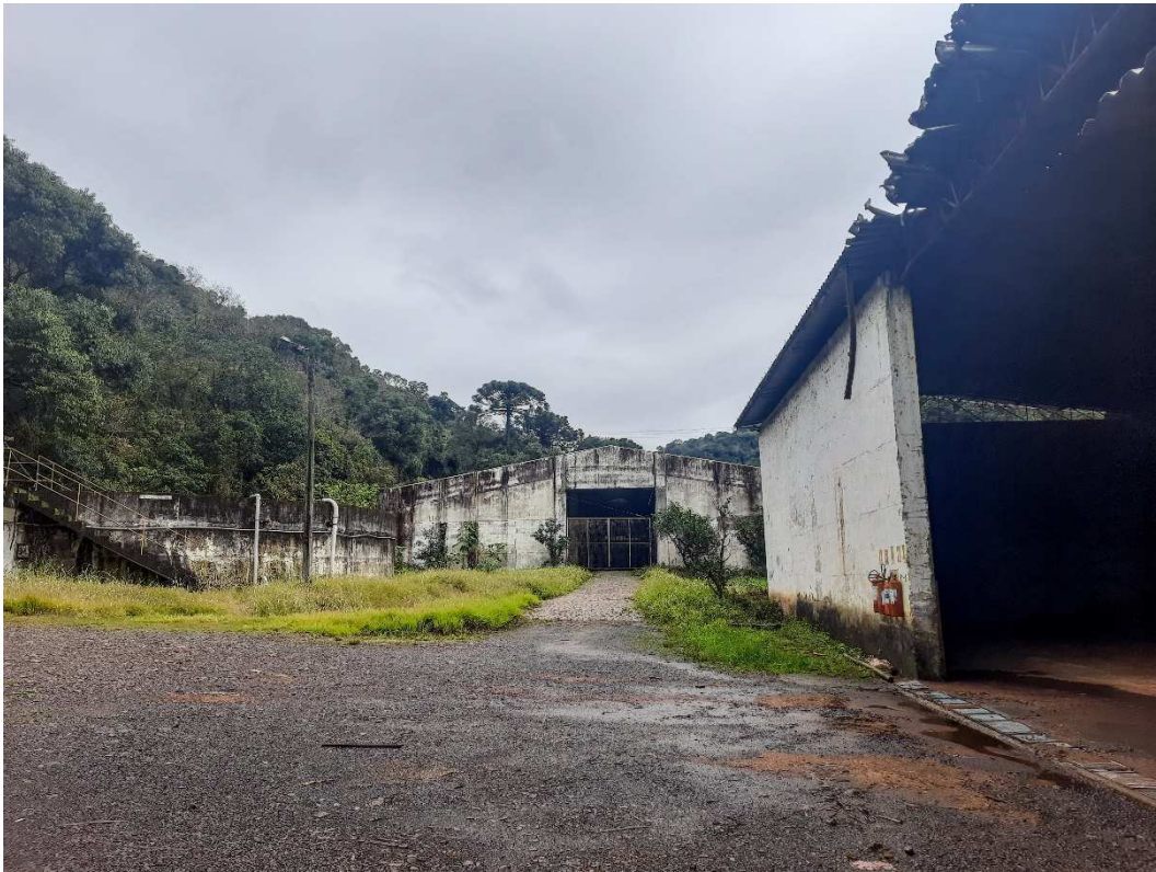
Fotografia 04 – Aspecto das construções do imóvel avaliado.
