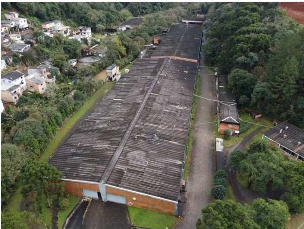
Fotografia 11 – Aspecto externo das construções do imóvel avaliado.
