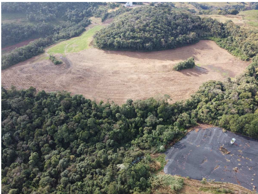
Fotografia 06 – Aspecto geral do imóvel avaliado.
