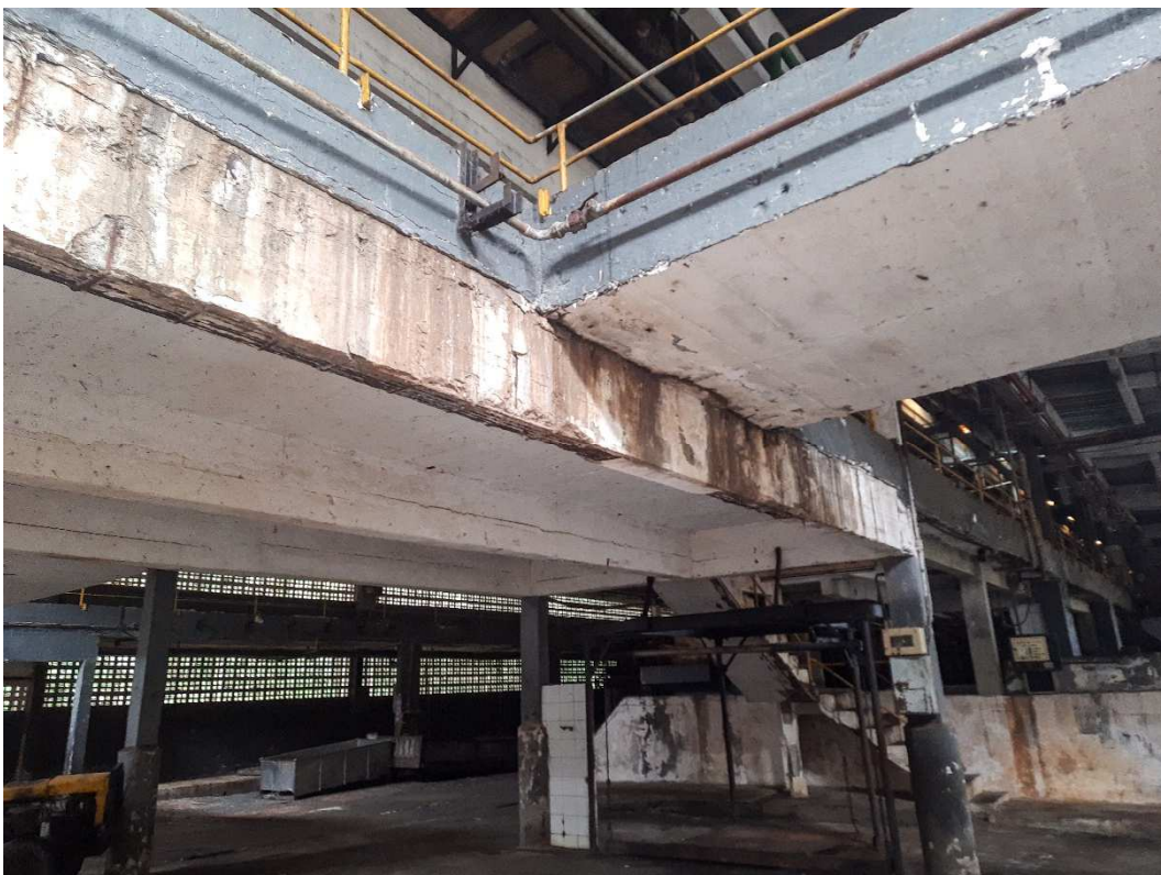
Fotografia 07 – Aspecto interno das construções do imóvel avaliado.
