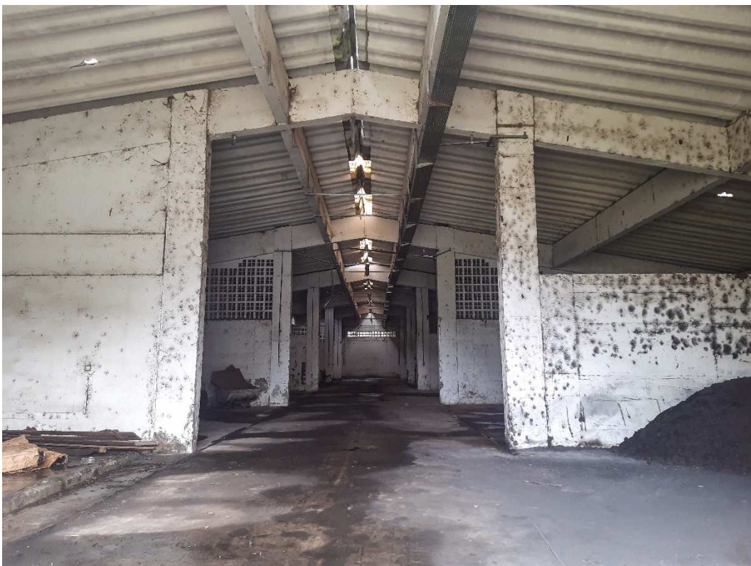
Fotografia 04 – Aspecto das construções do imóvel avaliado.
