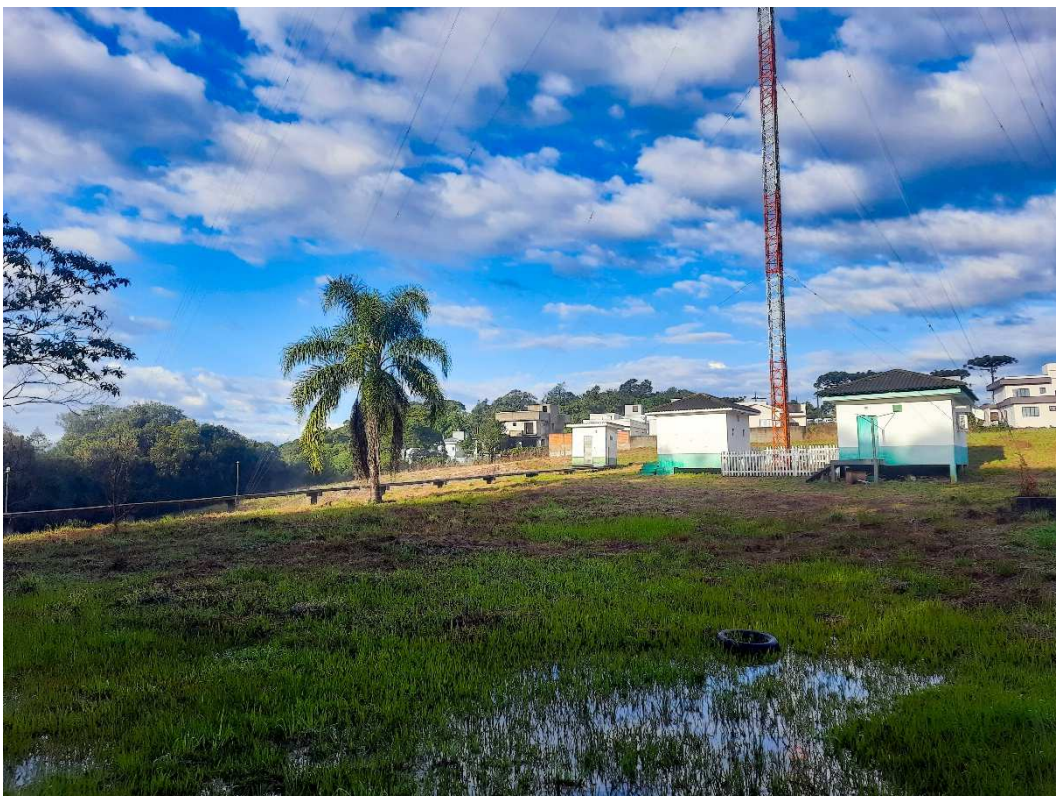
Fotografia 05 – Aspecto geral do imóvel avaliado.
