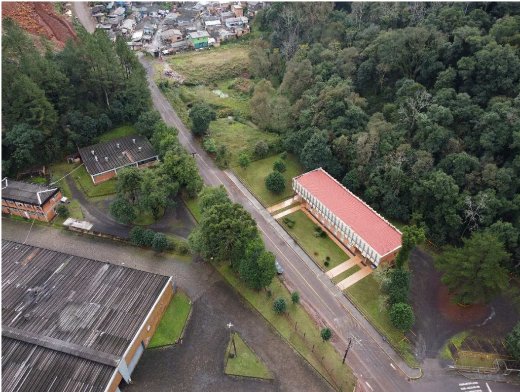
Fotografia 08 – Aspecto do imóvel avaliado e seu entorno.
