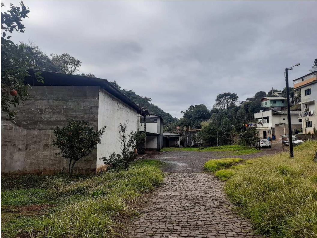
Fotografia 04 – Aspecto geral do imóvel avaliado.
