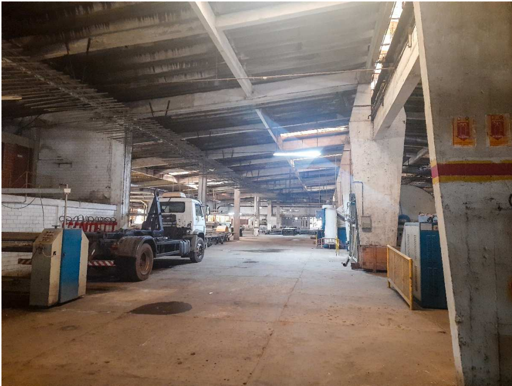
Fotografia 08 – Aspecto interno das construções do imóvel avaliado.
