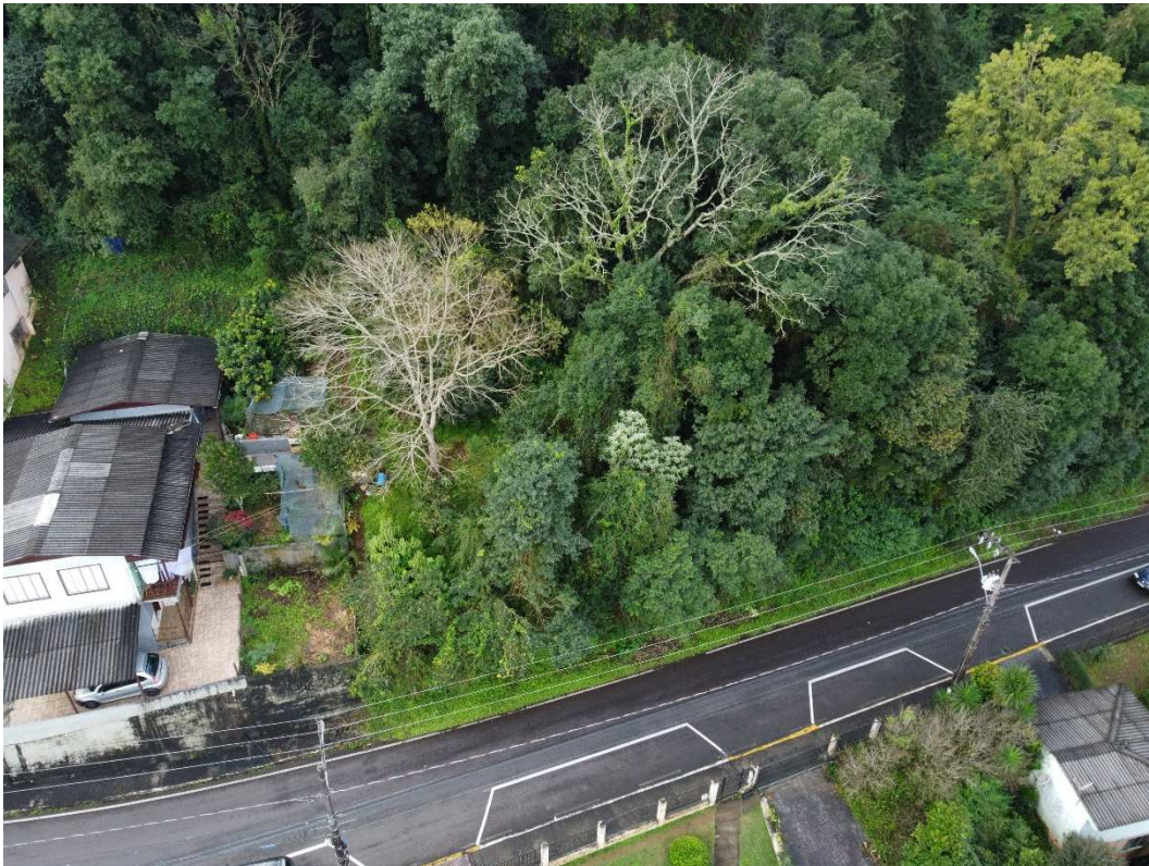
Fotografia 04 – Aspecto geral do imóvel avaliado.
