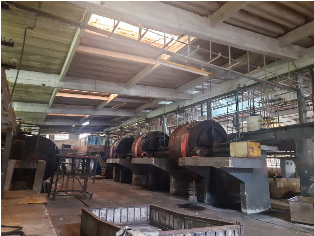
Fotografia 06 – Aspecto interno das construções do imóvel avaliado.
