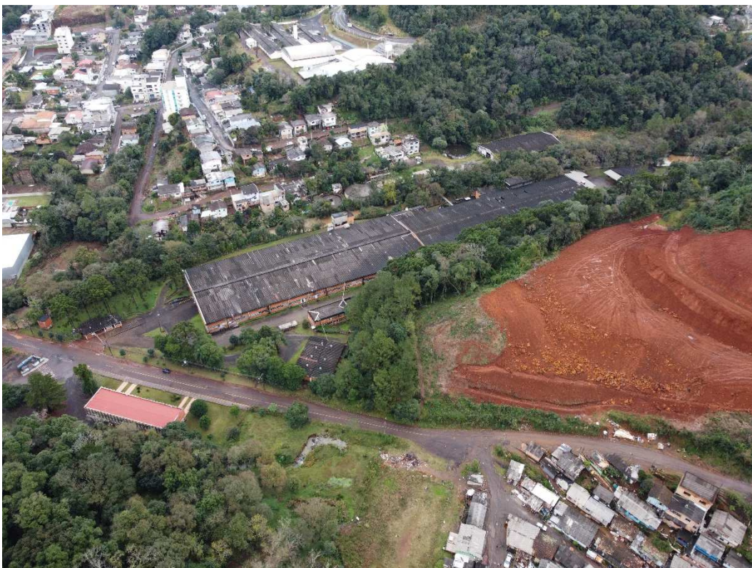
Fotografia 08 – Aspecto do imóvel avaliado e seu entorno.
