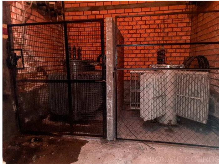
**Descrição: Transformador de Potência 500KVA Entrada 24500V e Saída 380V**
