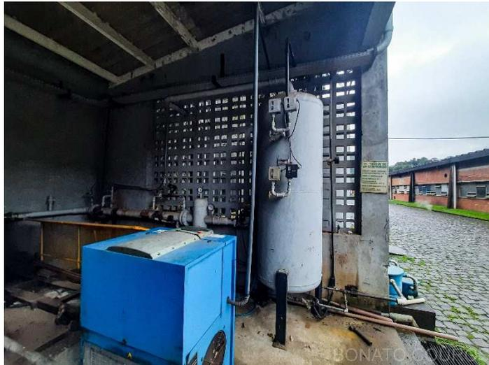
**Descrição: Tanque em Aço Carbono Pulmão de Ar – 800X2000MM**
