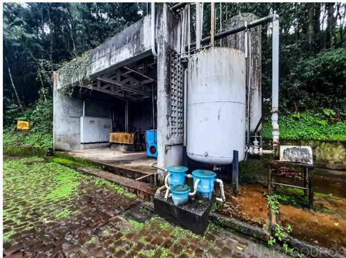
**Descrição: Tanque em Aço Carbono Água – 1500X2500MM**
