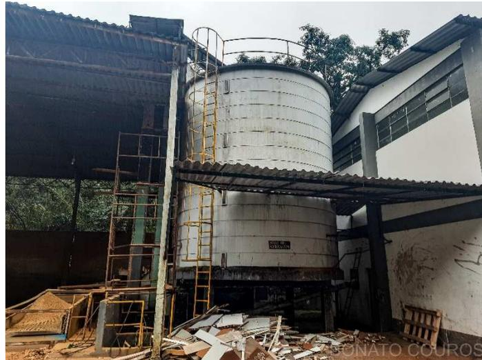
**Descrição:** Silo para Serragem 5500X7000MM Cap. 160 M<sup>3</sup>
