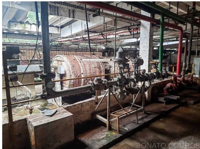
**Descrição: Tanque em aço carbono revestido por lã de vidro para água quente**
